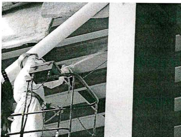
Рисунок 8 – Нанесение огнезащитного состава
