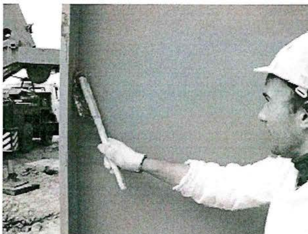
Рисунок 2 – Очистка обрабатываемой поверхности щеткой
